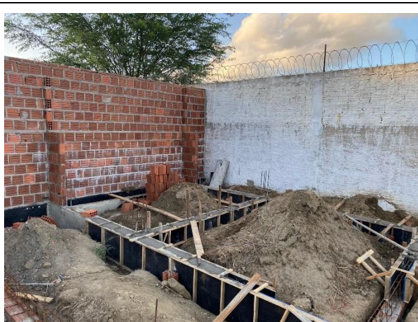
FOTO 19: Forma e concretagem das vigas baldrame;
