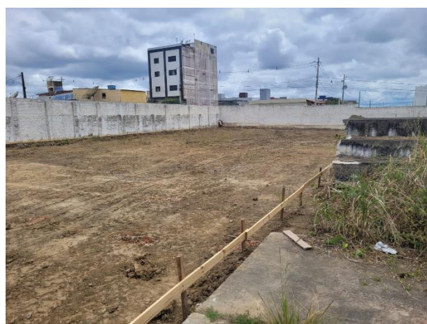
FOTO 5: Terreno após limpeza e gabaritos instalados;
