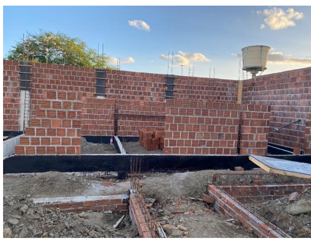
FOTO 21: Elevação de alvenaria;
