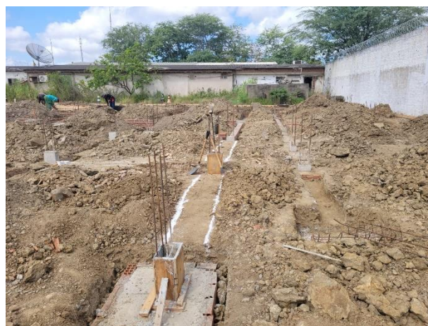
FOTO 18: Sapatas concretadas e reaterradas, pescoços concretados e baldrame em escavação;
