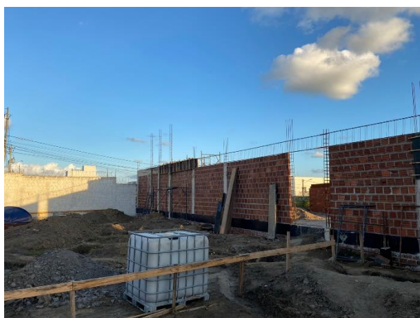
FOTO 23: Concretagem de pilares do muro;
