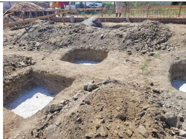
FOTO 9: Escavação de Sapatas das Salas;
