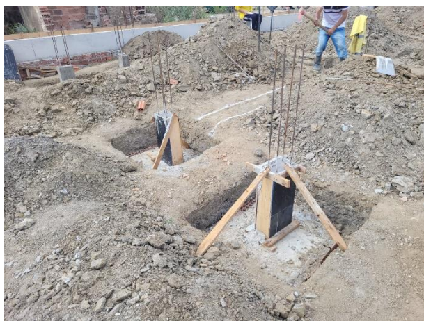
FOTO 17: Concretagem dos Pescoços de pilares;
