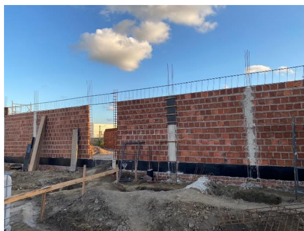
FOTO 24: Concretagem de pilares do muro;
