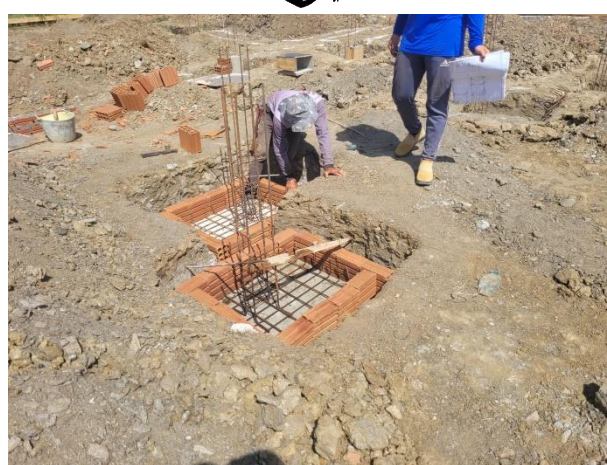
FOTO 14: Armações das Sapatas e pescoços de pilares;
