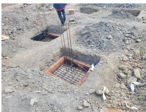
FOTO 13: Armações das Sapatas e pescoços de pilares;
