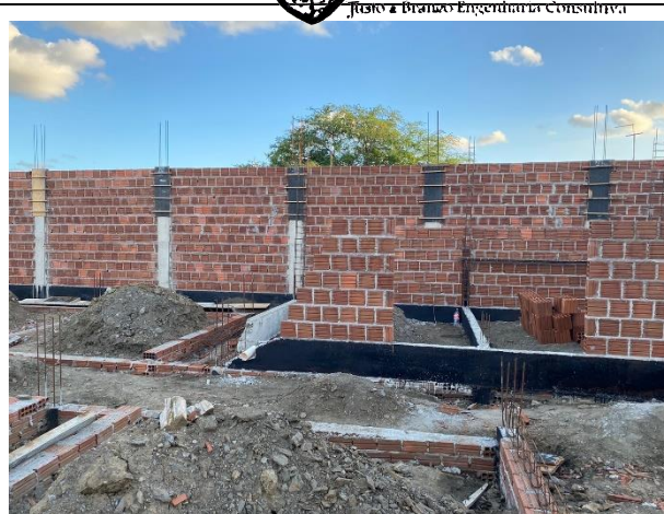
FOTO 20: impermeabilização das vigas baldrame;
