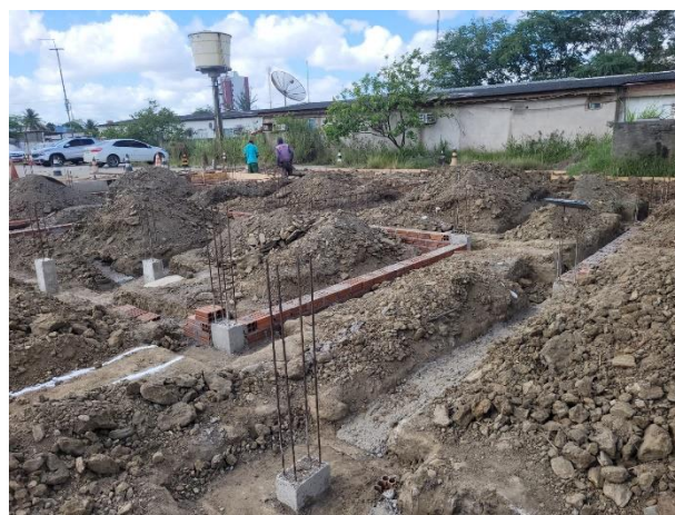
FOTO 16: Sapatas concretadas, pescoços concretados e baldrame escavadas;
