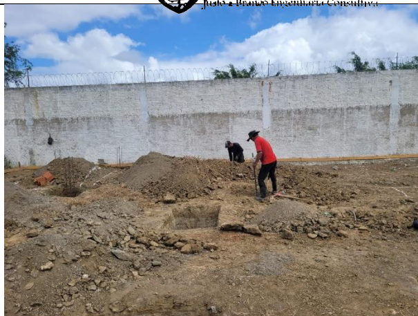
FOTO 8: Escavação de Sapatas das Salas;
