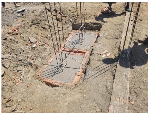
FOTO 15: Sapatas em concretagem;
