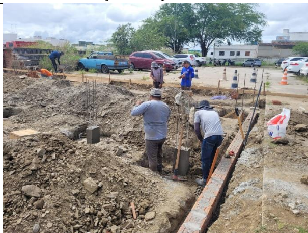
FOTO 8: Escavação de Sapatas das Salas;
