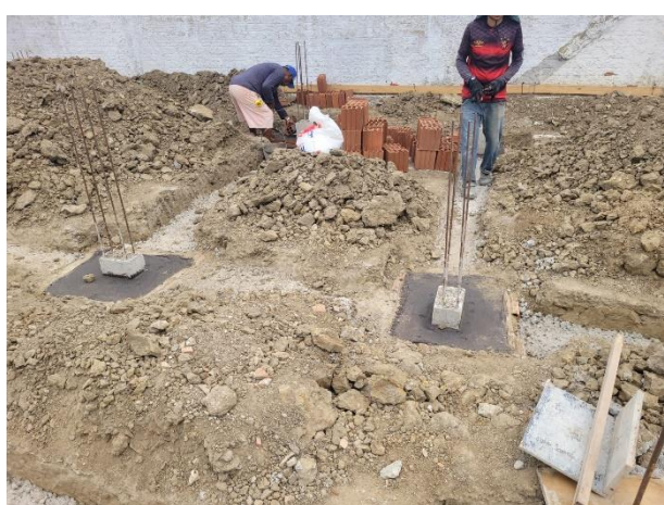
FOTO 1: Valas escavadas, concreto magro e sapatas impermeabilizadas;
