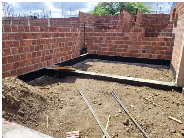
FOTO 12: Alvenarias de vedação e baldrame impermeabilizados;
