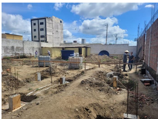
FOTO 5: Sapatas e pescoços de pilares;
