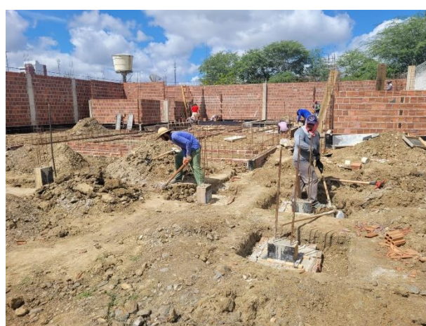
FOTO 2: Escavações de valas para baldrame;
