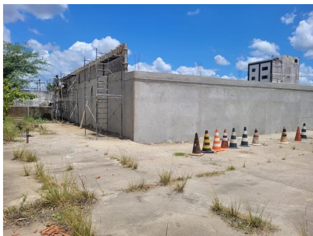
FOTO 23: Chapisco e massa única do muro;
