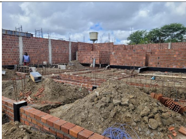
FOTO 7: Alvenaria de 1 vez, armações da baldrame e impermeabilização;
