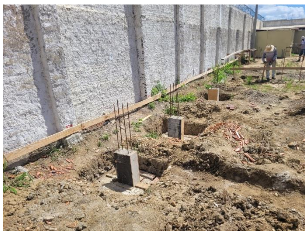
FOTO 3: Sapatas e pescoços de pilares;
