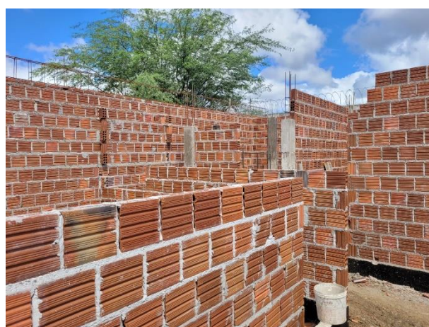
FOTO 14: Armações de vigas;
