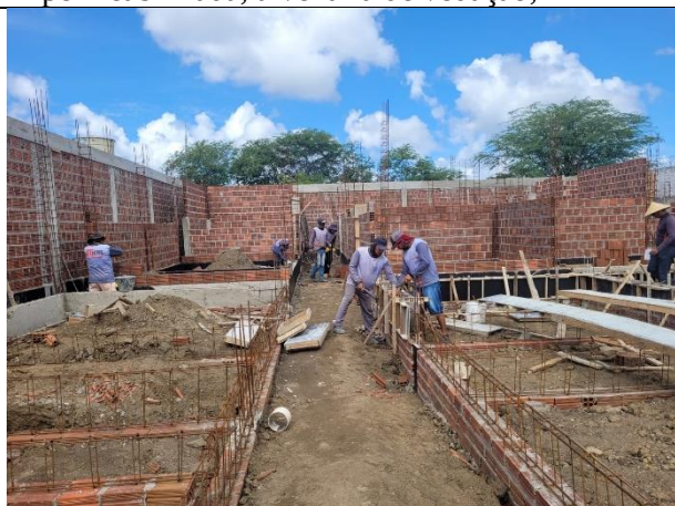
FOTO 9: Baldrame concretado e impermeabilizado, alvenaria de vedação;
