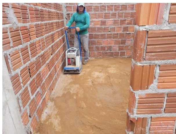
FOTO 16: Compactação de aterro;
