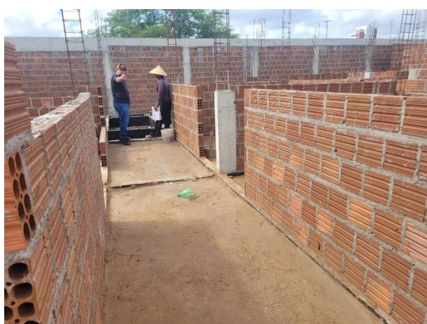
FOTO 17: Aterramento de ambientes;
