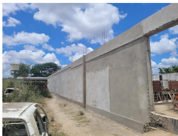
FOTO 22: Chapisco e massa única do muro;
