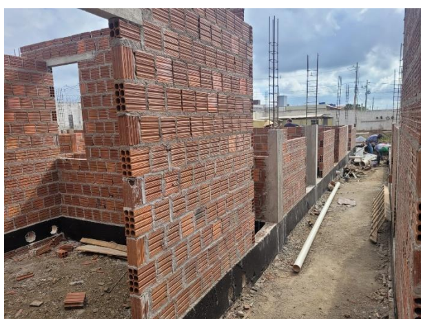
FOTO 19: Alvenaria de vedação – Área das salas;
