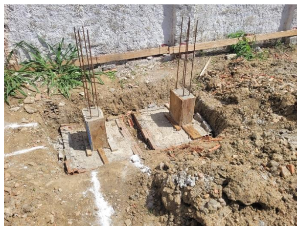
FOTO 4: Sapatas e pescoços de pilares;
