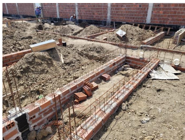
FOTO 6: Alvenaria de 1 vez e armações das baldrame;
