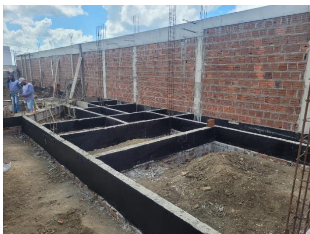
FOTO 15: Baldrame executadas e impermeabilizadas;
