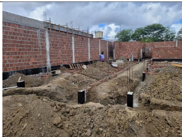
FOTO 8: Alvenaria de 1 vez, armações da baldrame e impermeabilização;
