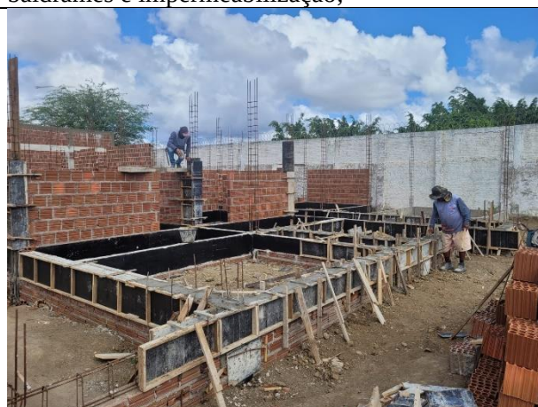
FOTO 10: Montagem de forma para baldrame;
