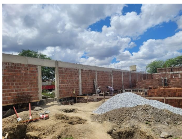
FOTO 20: Estrutura do muro executada;
